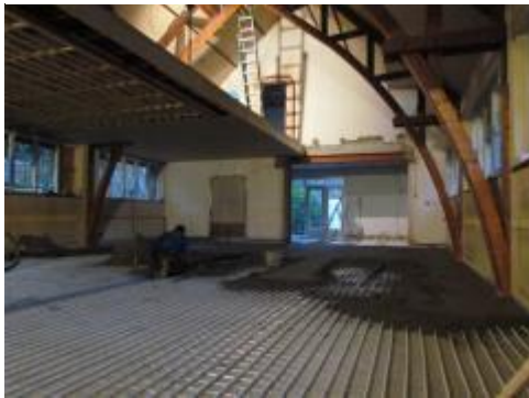
Cementdekvloer met vloerverwarming en isolatie Plaatsing silo met mortelcertificatie t.b.v. realisatie cementdekvloer
