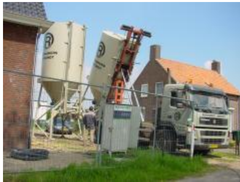
Cementdekvloer met vloerverwarming en isolatie Plaatsing silo met mortelcertificatie t.b.v. realisatie cementdekvloer
